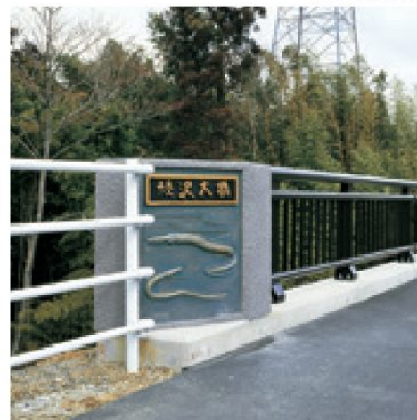
うなぎ沢大橋
