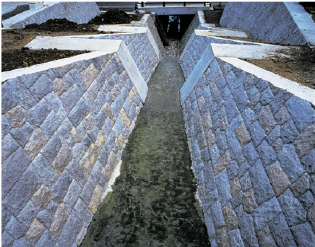
南沢川砂防ダム
