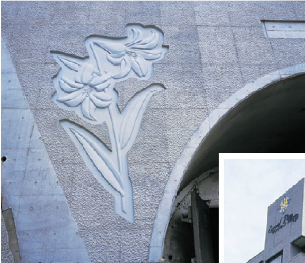
売木トンネル
